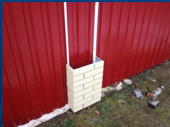
3. Устанавливаем следующую панель в стыковочные пазы первой панели и повторяем пункт 2.
